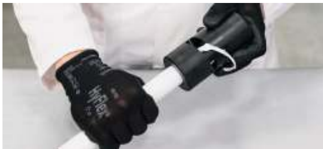
Рис. 29. Резка (труба steelPRES в изоляции из полипропилена).
